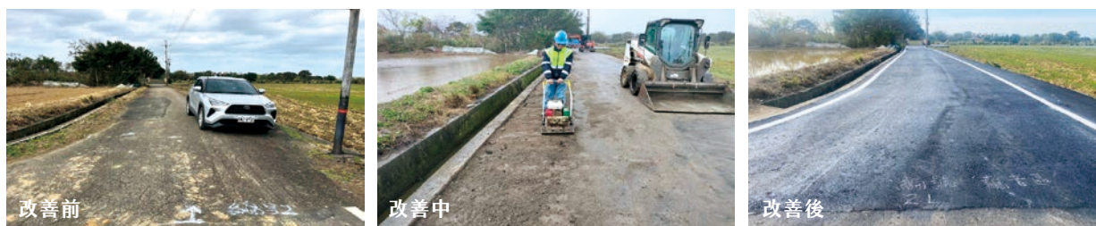
圖 49.農地重劃區緊急農水路改善前、改善中及改善後情形
