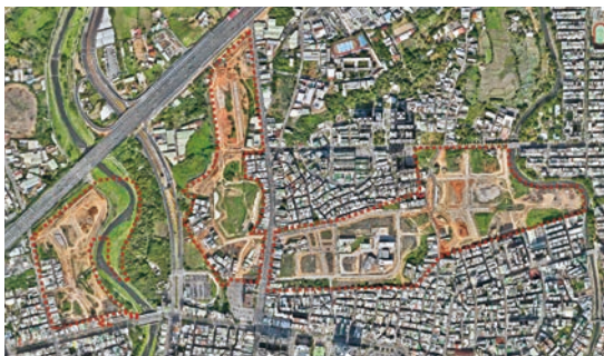
圖 53.機場捷運A21案公共工程開發中期(114年12月)空拍
