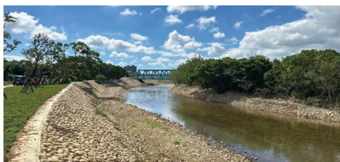
老街溪右岸斷面34至斷面41護岸新建工程(非都市土地)
