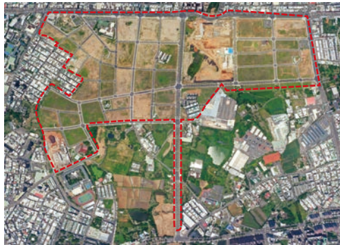
圖 51.中壢運動公園案公共工程開發後期(114年5月)空拍
